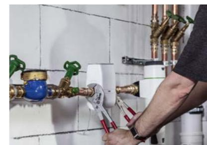
Komponente se međusobno povezuju na pritisak dugmeta uređaja za kontrolu vodovodnih instalacija, a zatim se prilagođavaju granične vrednosti u aplikaciji.
